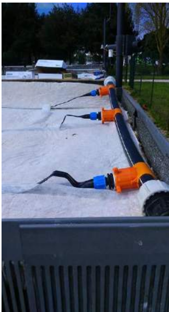
Raccord des nourrices d'irrigation Toiture n°2 : système de collier prise en charge auto perçant (CPC)
