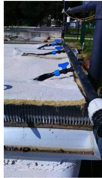
Raccord des nourrices d'irrigation Toiture n°1 : Branchement classique
