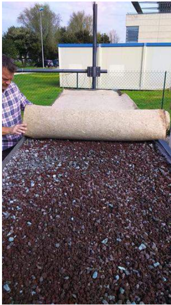
Dépôt du tapis de rétention d'eau en chanvre
