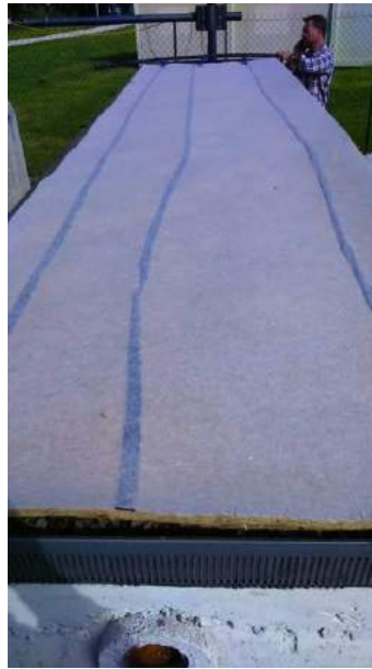
Mise en place du tapis d'irrigation
