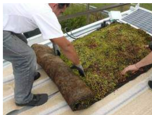
Figure 2a – Pose des tapis de sedum
