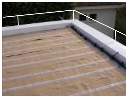
Figure 6a – Tapis sec d'irrigation Vertige® installé sur la toiture
