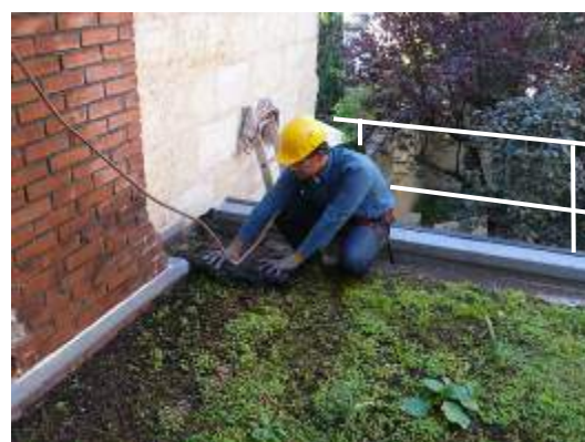
Figure 2b – Pose des tapis de sedum
